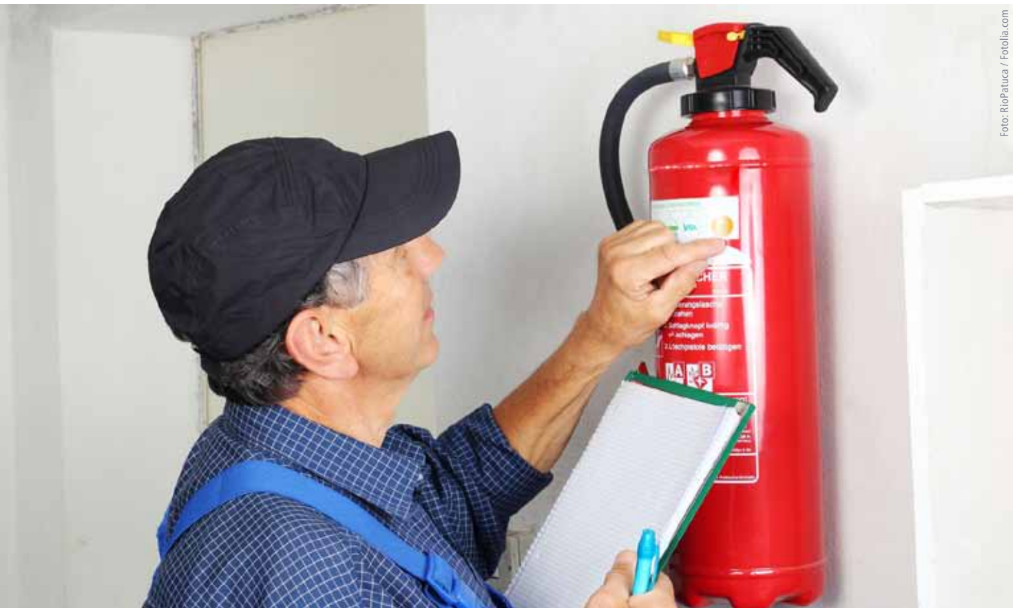
Abb. 1: Aufbringen einer Siegelmarke auf einem konventionellen Feuerlöscher durch den Dienstleister nach einer Instandhaltung
