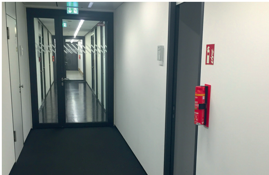
Feuerlöscherspray in der Konzernzentrale der Fraport AG
